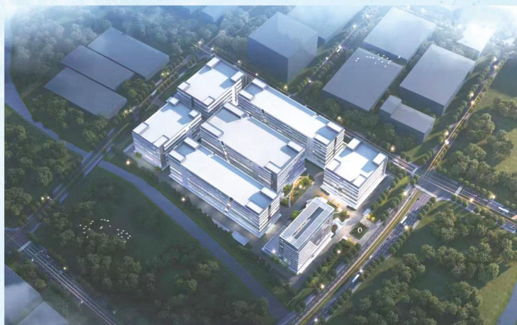
湘家荡高端装备产业园(主体工程)二期,总建筑面积125439 \text{m}^2 , 质量目标嘉兴市建设工程南湖 杯奖(优质工程)。
